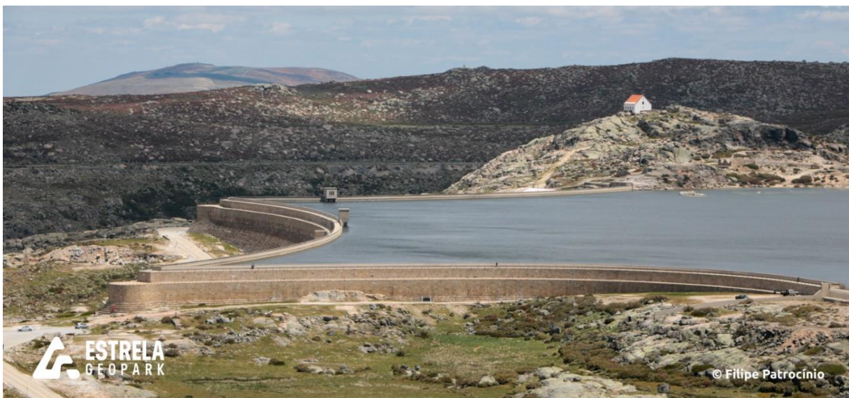
Figura 2. Vista do Paredão da Barragem da Lagoa Comprida.
